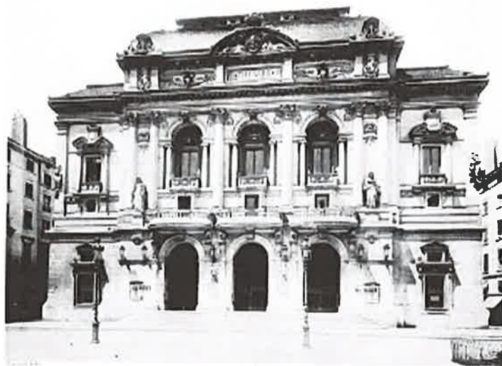
Theatre des Célestins avant rénovation
